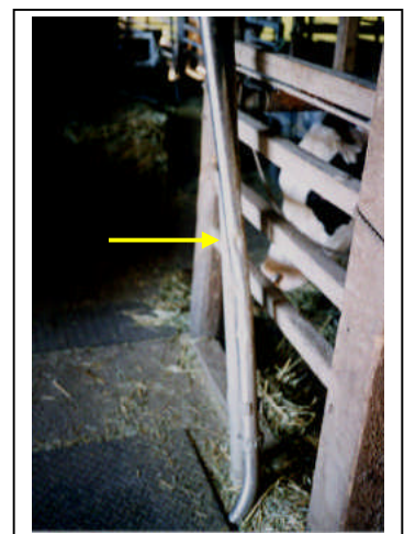
写真92 配管の凹み
